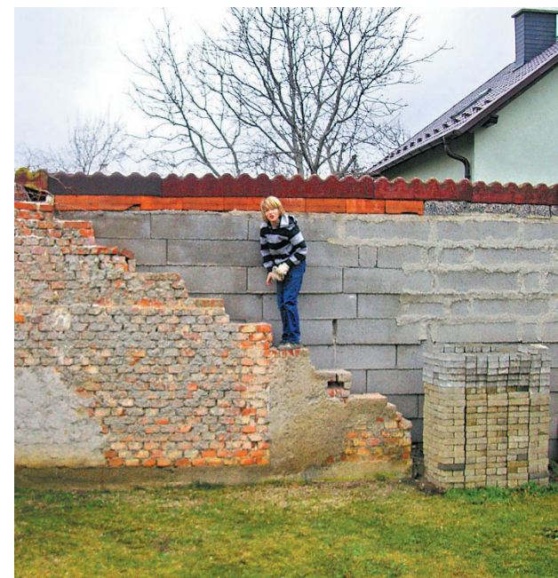
Auch die Außenanlagen müssen auf Vordermann gebracht werden, da wartet aber noch viel Arbeit auf mich“ empfangen wird.
